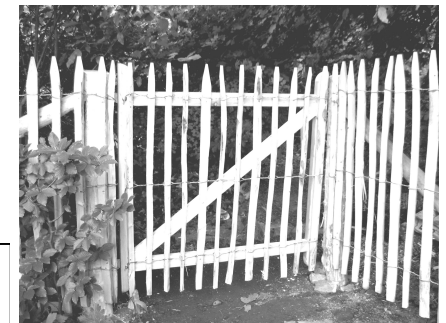
Torrahmen aus Lärchenkantholz mit befestigtem Zaunstück, Höhe 100 cm - 4 cm Drahtwicklung
